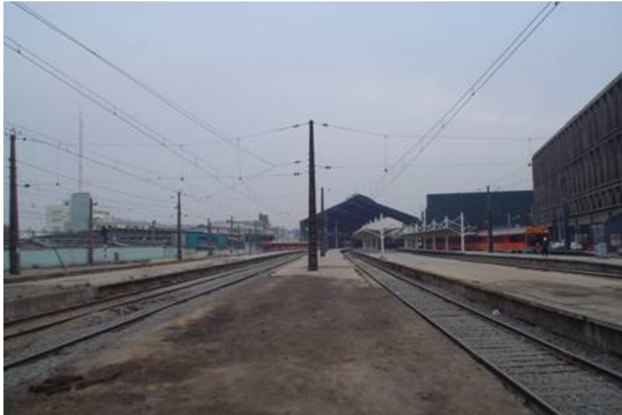
HOY. Imagen de un área urbana central deteriorada (Santiago de Chile) . Registro del autor.
